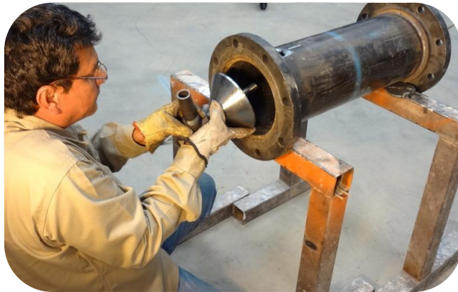
Instalación sub-ensamble cono de inyección
