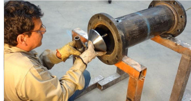
Instalación sub-ensamble cono de inyección
